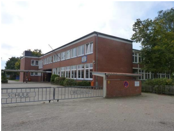
Grundschule Wechold (zweizügig)
