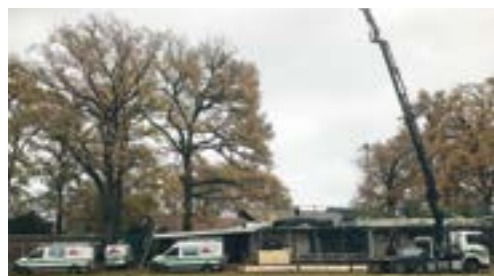
Der Beginn der Dacherneuerung
