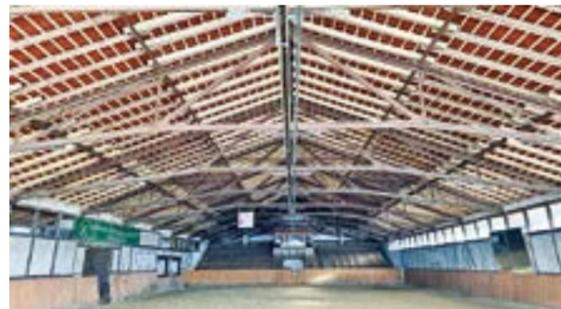
Die innere Hallenansicht nach der Sanierung. Sämtliche Dachsparren wurden durch technisch getrocknete Konstruktionshölzer verstärkt und die vorhandenen Unebenheiten beseitigt.
