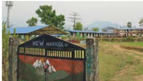
Die New Marigold-Schule wurde umfangreich saniert
