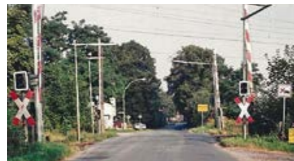
So sah der ehemalige beschränkte Bahnübergang aus Richtung Ahnebergen aus. (Fotos: Werner Rengstorf)
