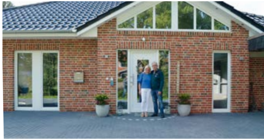
Corinna und Ehler Troue laden zum Tag der offenen Tür am Samstag, den 22. Oktober 2022 ein. Nicht nur die Optik des Gebäudes macht einen sehr angenehmen, harmonischen Eindruck. Genauso wichtig ist es, für ein angenehmes, barrierefreies Betreten des Gebäudes zu sorgen. Beides ist bei diesem Neubau ausgezeichnet gelungen.
