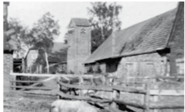
Rechts im Bild ist der Kehlbecks Hof zu sehen und der Transformator, der vor Jahren in Warpe abgerissen wurde. Die Tischlerei Hustedt befindet sich hinter dem Transformator.
