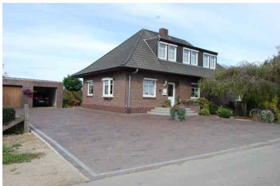
stark versiegelte Hoffläche
