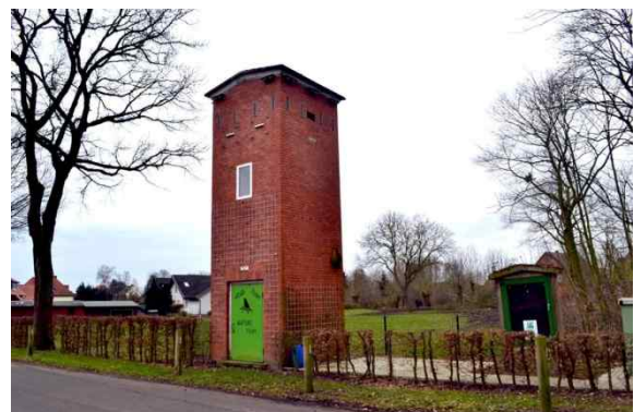
Wienbergen (ehemaliger Transformator, der für Naturschutzzwecke umgenutzt wurde)
