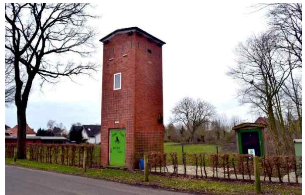
ehemaliger Trafo - umgenutzt als Wohnstube für Fledermäuse und diverse Vogelarten
