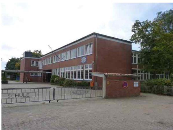
Grundschule Wechold (zweizügig)
