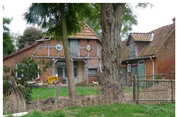
Hoher Sanierungsstau erkennbar
