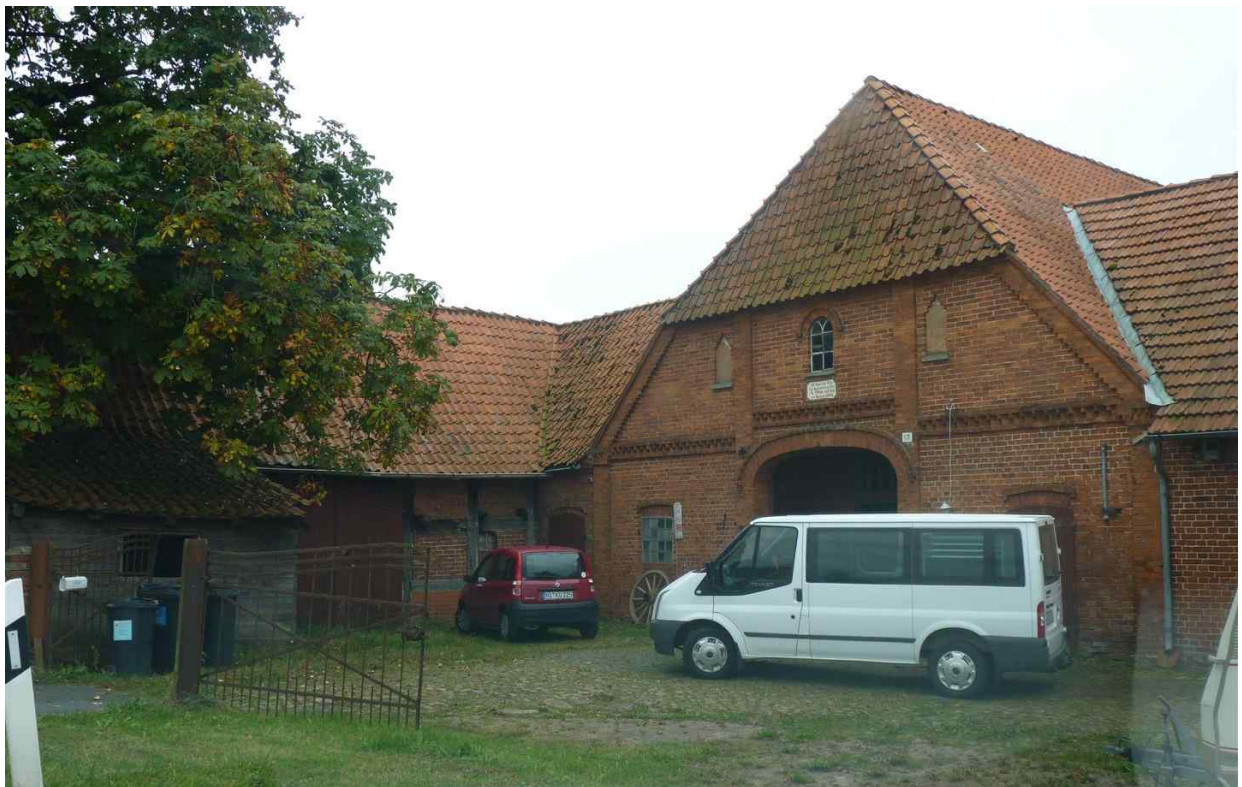
Ortsbildprägende Resthofanlage mit typischer Dachform und alter Pfanneneindeckung
