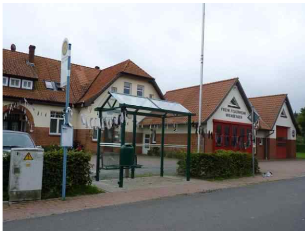
Feuerwehrhaus Wienbergen (Stützpunkt)
