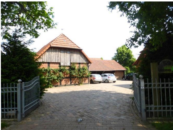
Abbildung 3: Erhaltene und sanierte Hofstelle mit Garten- und Landschaftsbaubetrieb in Wechold 59
