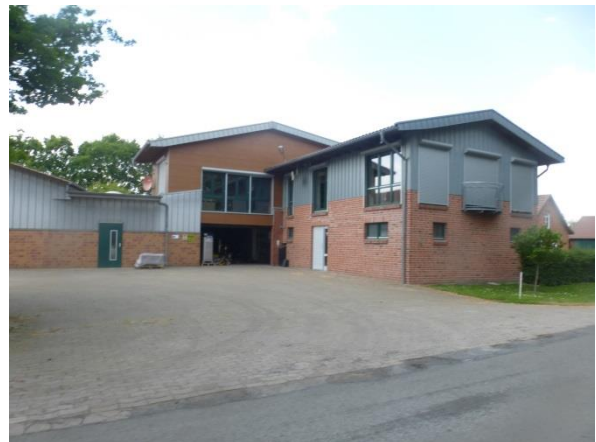
Abbildung 4: Umgebaute und erweiterte Hofstelle mit Gewerbenutzung in Wechold 46
