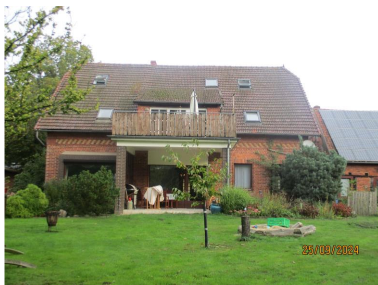
Blick auf das Wohnhaus zur Hofstelle Nr. 1
