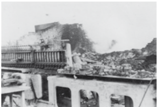
Firma Prigge in Stedorf, 29.03.1944 – Schäden nach Luftangriff
