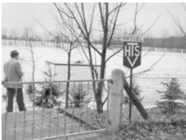
Das Foto zeigt den überfluteten Hasseler Sportplatz. Die Tore schauten ca. einen Meter aus dem Wasser und auch die damalige Verkaufsbude hatte nasse Füße bekommen. (Bilder Sammlung Hermann Diers)
