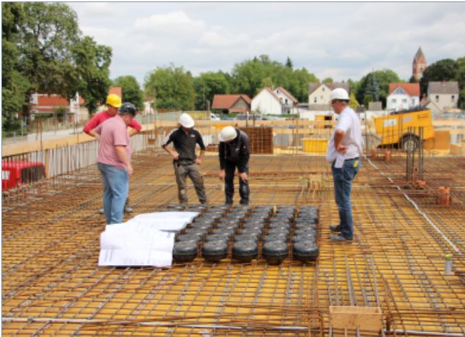
Kunststoffhohlkörper werden auf dem Dach verteilt und mit Beton umschlossen.
