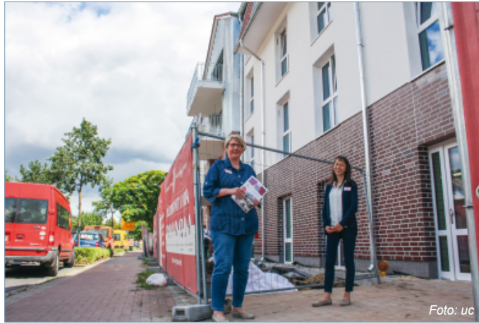
Bis Mitte August befanden sich die Büros von Einrichtungsleiterin Gabriele Schwarz (l.) und Pflegedienstleiterin Angela Zarrath (r.) noch inmitten der Baustelle.
