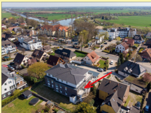
Energieausweis: 36,9 kWh/m 2 a, Erdgas, Effizienzklasse A
